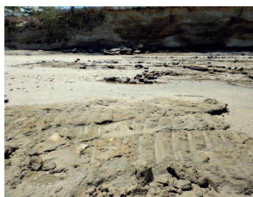
Zone d'entrée des canalisations à travers les dalles basaltiques – Peuplements très faibles
