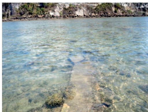
Déplacement d'un cavalier protégeant la canalisation dans cette zone exposée ; et colonie de S. pistillata
